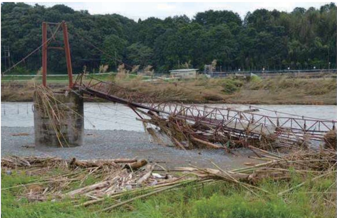
相良村西村（被災状況）
