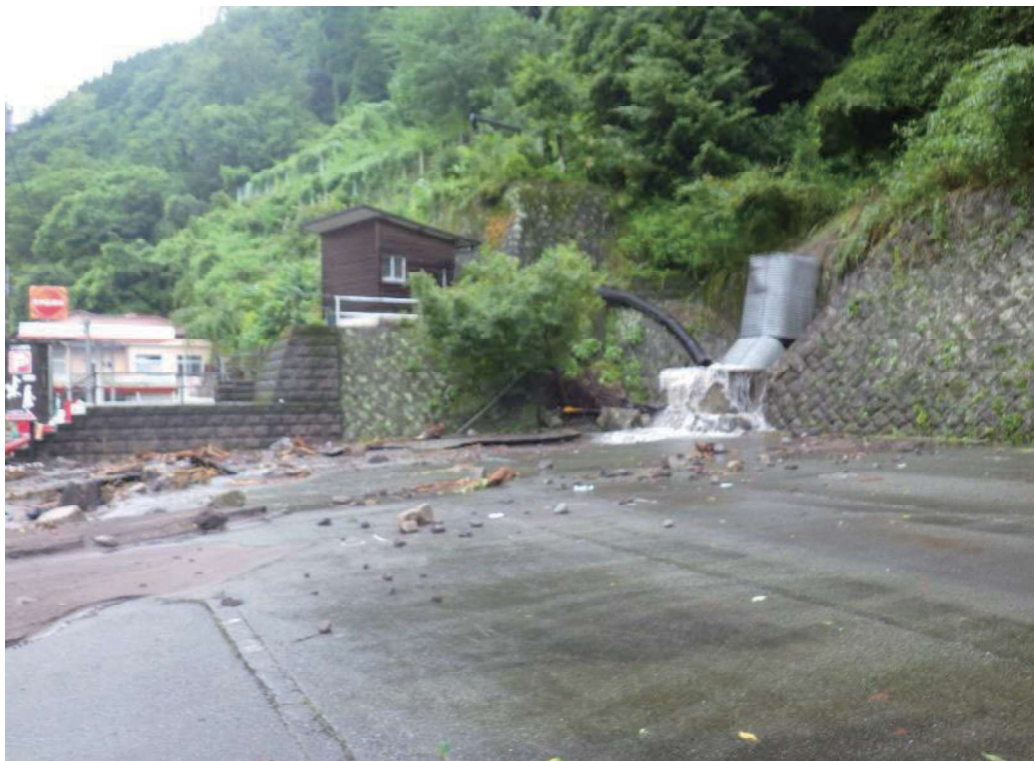
町道湯町線（治山事業施設からの流水）
