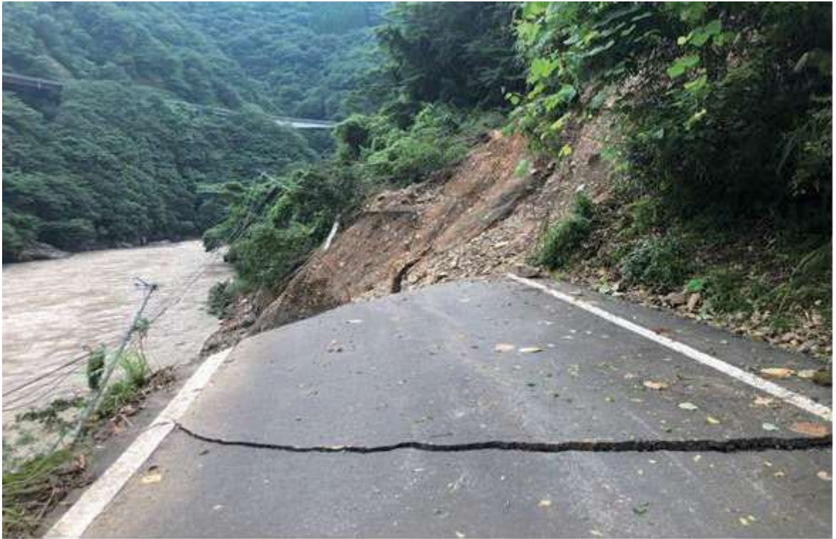
五木村村道川辺川線（被災状況）
