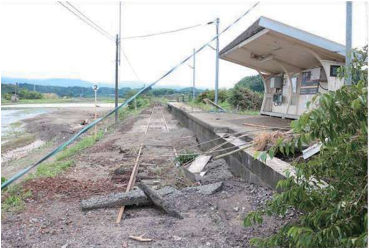
相良村川村駅（被災状況）
