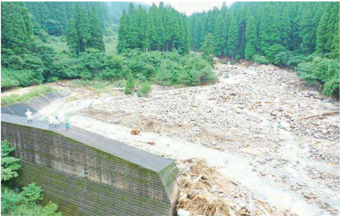
水上村湯山川堆積土砂
