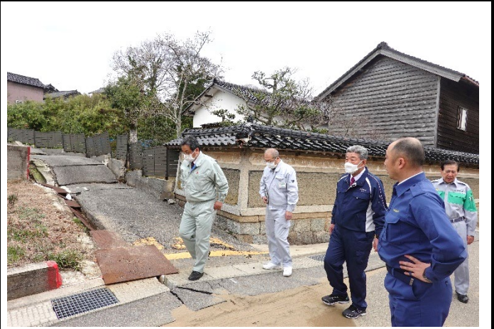
液状化被害を受けた柳瀬地区 4
