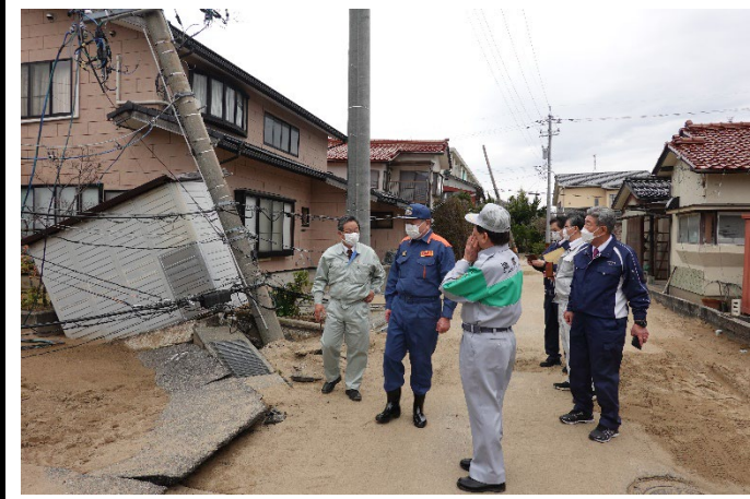
液状化被害を受けた西荒屋地区3
