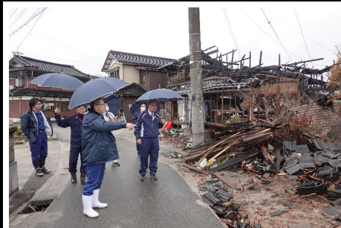
津波被害が発生した白丸地区 3
