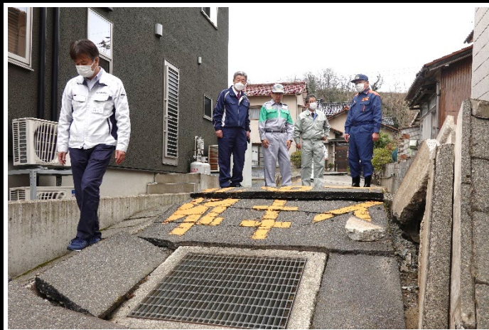
液状化被害を受けた西荒屋地区 5
