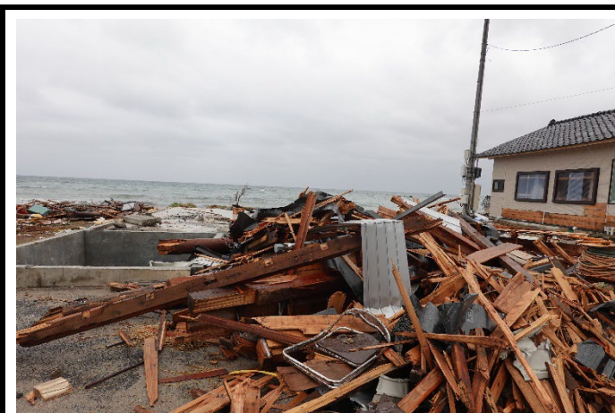
津波被害が発生した白丸地区 1
