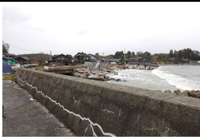
津波被害が発生した白丸地区 6
