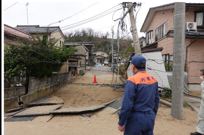
液状化被害を受けた西荒屋地区1
