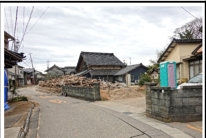
液状化被害を受けた柳瀬地区 2
