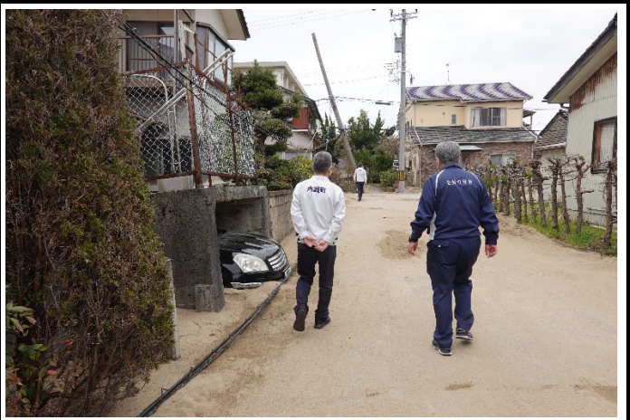
液状化被害を受けた西荒屋地区 6
