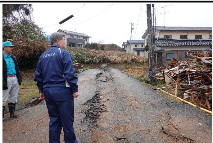
土砂崩れ被害が発生した由比ヶ丘地区 6
