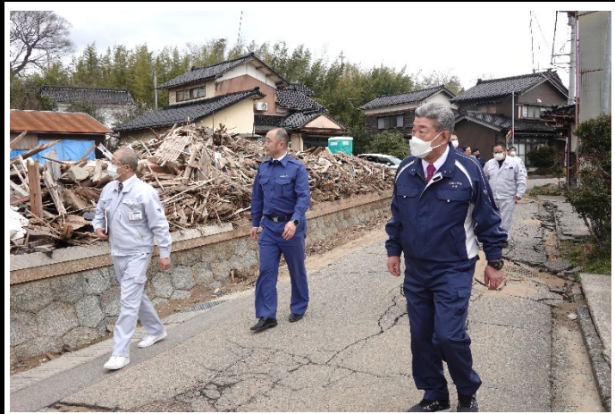
液状化被害を受けた柳瀬地区 3
