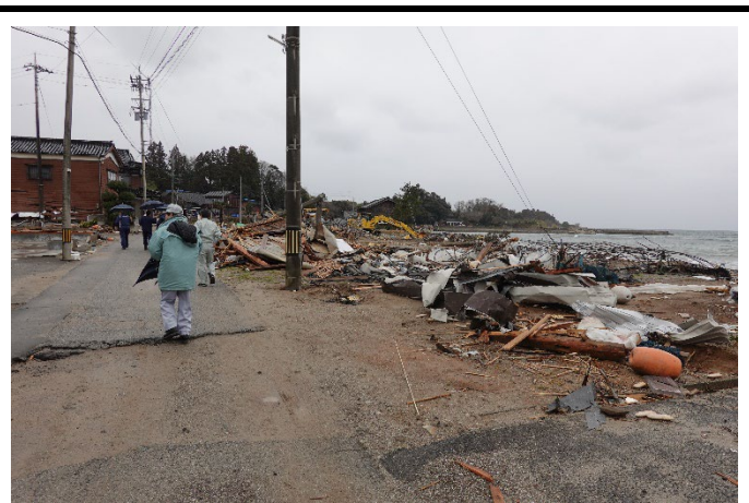
津波被害が発生した白丸地区 2
