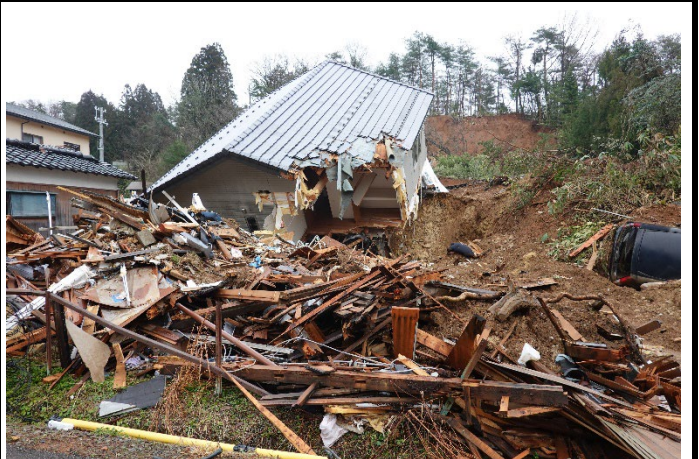
土砂崩れ被害が発生した由比ヶ丘地区4
