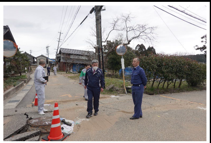
液状化被害を受けた柳瀬地区 6
