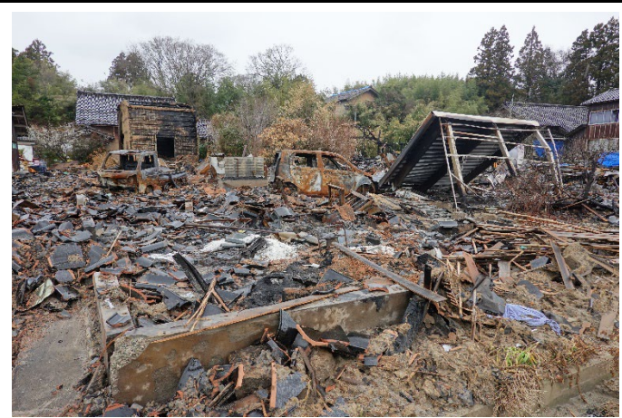
津波被害が発生した白丸地区 4
