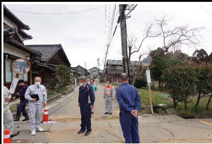
液状化被害を受けた柳瀬地区 5
