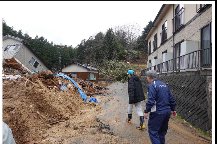
土砂崩れ被害が発生した由比ヶ丘地区2
