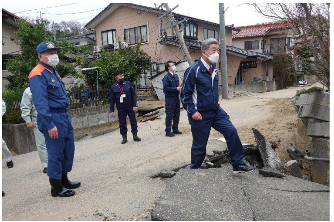
液状化被害を受けた西荒屋地区4
