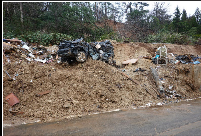
土砂崩れ被害が発生した由比ヶ丘地区1
